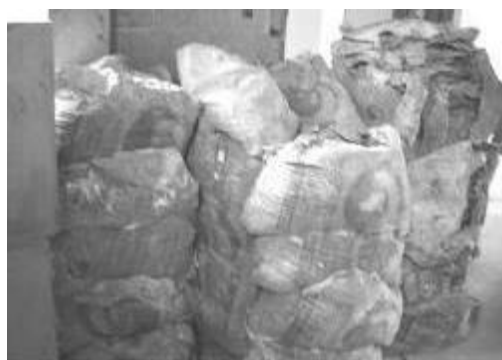
Figura 2 - Resíduo da pasta de gesso gerado em um pavimento revestido por um aplicador sem treinamento
