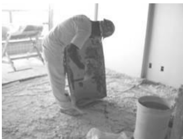
Figura 4 - Resíduo da pasta de gesso gerado em um cômodo revestido por um aplicador treinado
