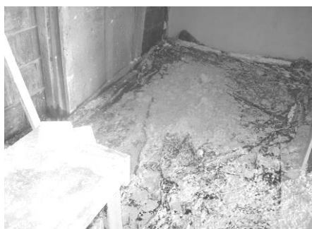
(a) Proteção do piso
