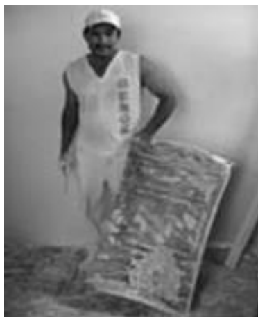
Figura 3 - Resíduo da pasta de gesso gerado na masseira de um aplicador treinado
