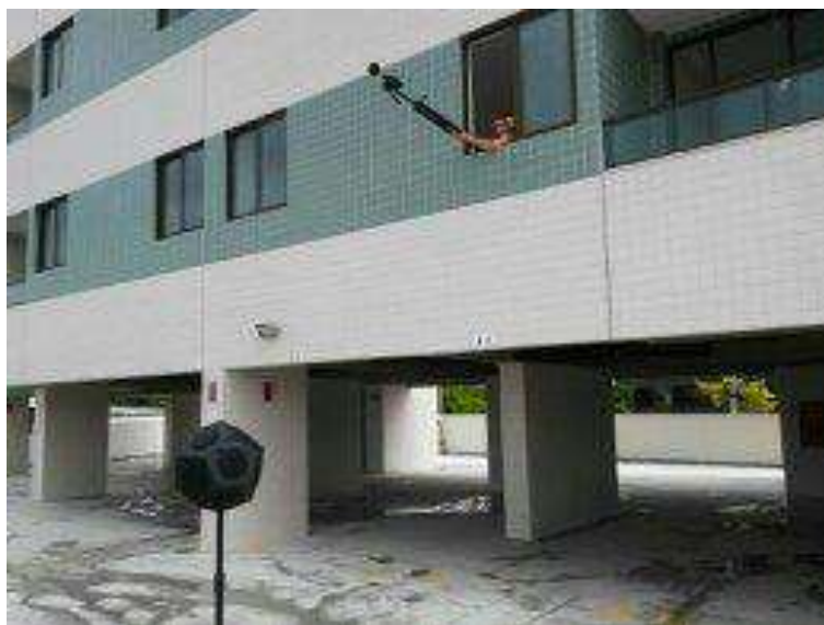
Figura 23 - Coleta do ruído de emissão no ensaio da vedação externo no 1º pavimento
