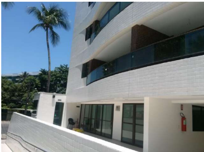
Figura 30 - Recuo da vedação E3 em relação a E2 na Obra 2
