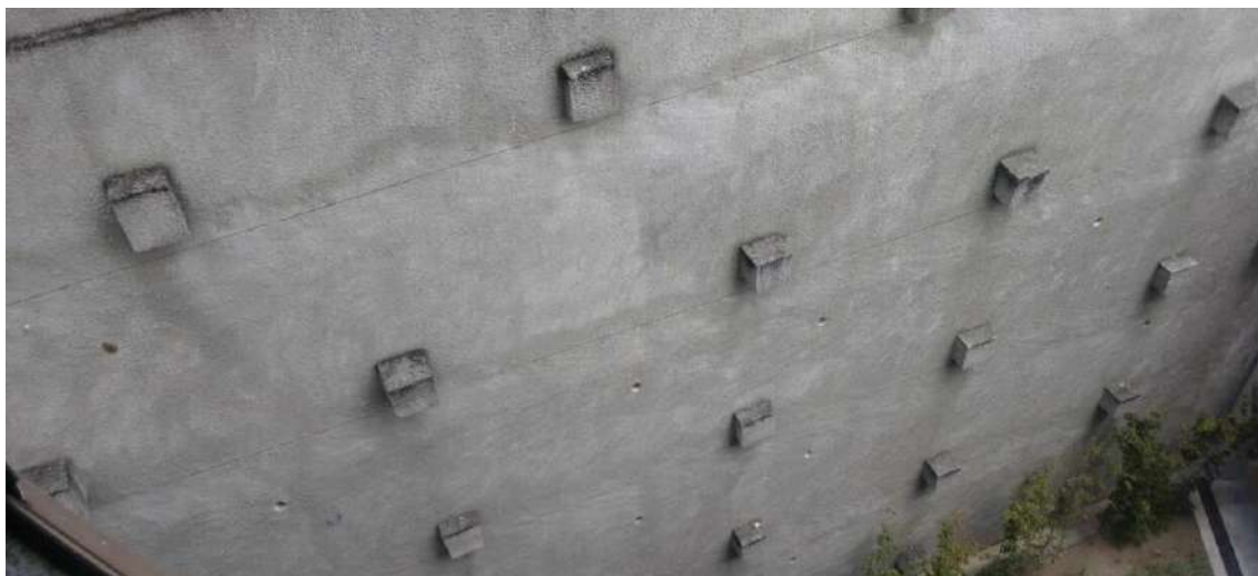
Figura 16 - Muro de contenção na Obra 14
