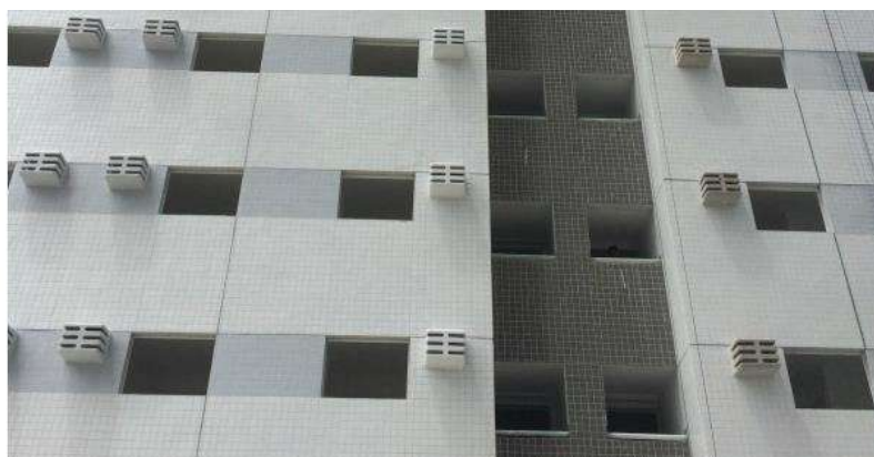
Figura 32 – Pré-moldados de ar condicionados na fachada dos dormitórios
