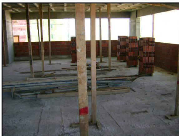
**Figura 4.19** - Assentamento das alvenarias externas
