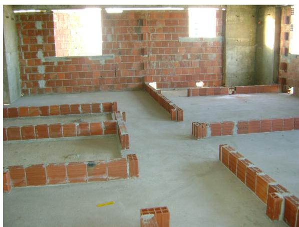
**Figura 3.7** – Marcação de 1ª fiada de alvenaria de vedação
