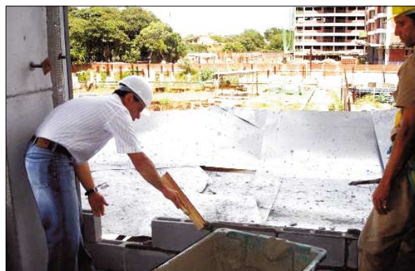
Figura 2 – Capacitação através de treinamento: a) no escritório com as equipes da obra e da ABCP, b) no canteiro – assentamento de argamassa com palheta
