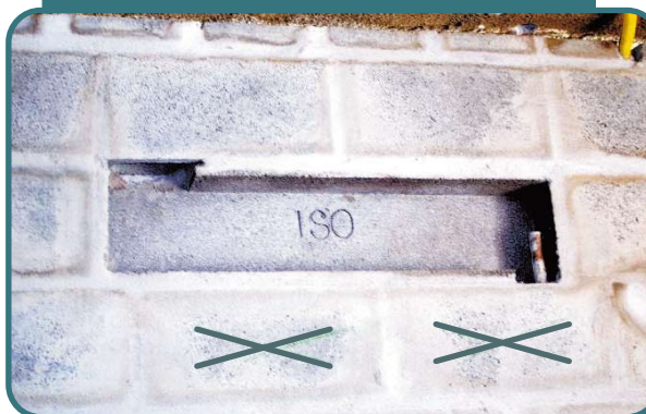
Figura 3 – Marcação dos blocos para a avaliação do indicador de perdas
