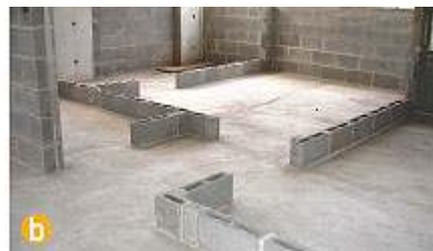
Figura 1 - Alvenaria de vedação: a) tradicional - desperdício, sujeira e tijolos assentados quebrados; b) racionalizada - organização e redução de perdas e de consumo
